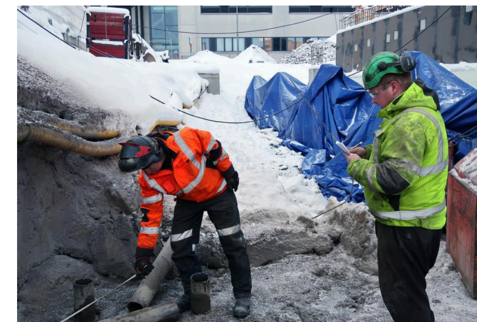
Toni Virtanen (vas.) ja Arttu Karppi mittaavat nosturiperustusten paalujen paikkoja.
