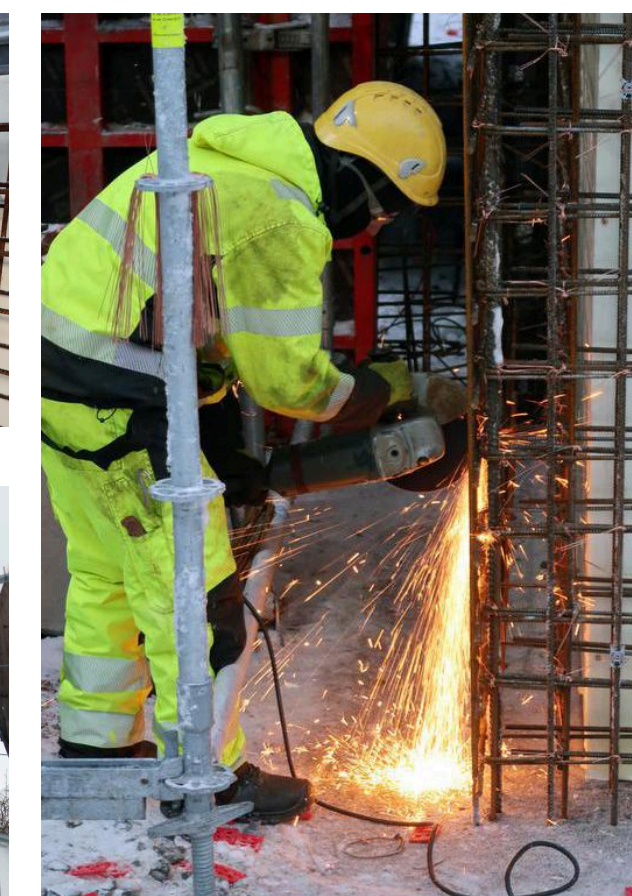
Maanpaineisnä vaatii tiheän raudoituksen.
